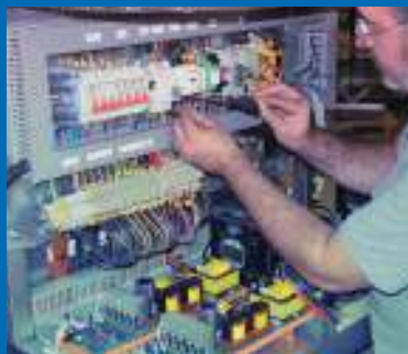
Assemblaggio quadri elettrici
