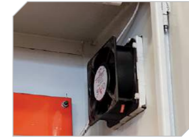
Elektrik panosu soğutma sistemi Electric panel cooling system
